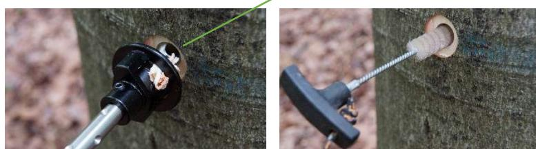
Stufenbohrung herstellen, Bohrloch säubern, Bohrloch desinfizieren, Harz einbringen, Plattformbolzen eindrehen.
